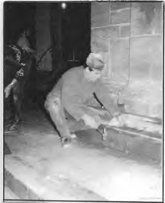
Im Jahr 1977: Maurermeister Bruno Stech arbeitete an der neuen Treppe vor der Kirche
