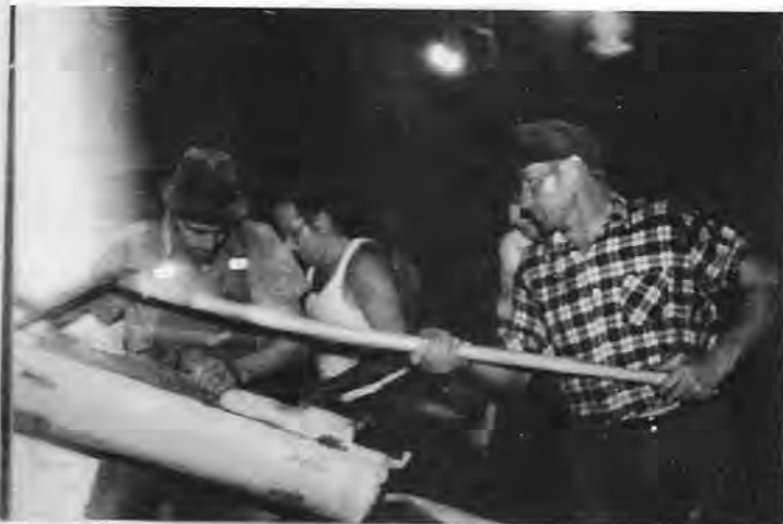
Noch abends zur späten Stunde bei Betonierungsarbeiten rechts: Friedrich Sester (1933 – 1997), Renchtalstr. 17
